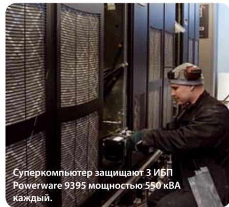
разработчиками Eaton. Это первая в своем классе система электропитания, фактически состоящая из двух источников, объединенных в одном корпусе. В 9395 реализована запатентованная технология Hot Sync®, отвечающая за беспроводную параллельную работу и резервирование ИБП. 9395 – самый мощный продукт в линейке Powerware. Кроме того, это одно из самых надежных решений для защиты электропитания ответственного оборудования», - отмечает менеджер по продукции Eaton **Яри Ниёминен**. ■
